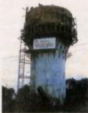
"RESERVORIO ELEVADO YARINACUCHA"
