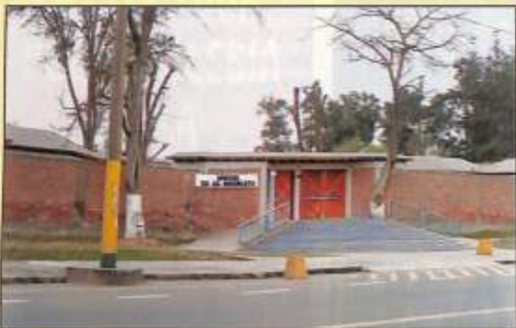
La entrada propia al complejo inicial da directamente a la Av. Circunvalación el Golf de los Incas en la parte media de la pared del Colegio.
